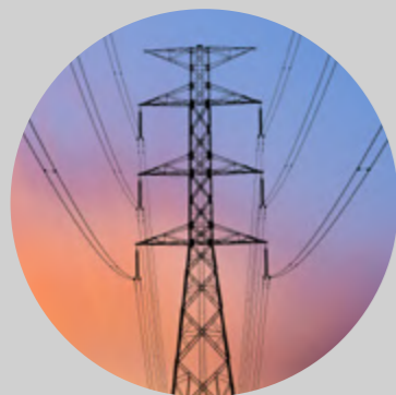
ENERGIETECHNIK INKL. ZÄHLER, MESS- UND PRÜFGERÄTE
