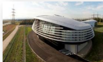
Hauptschaltwarte der APG (in 1100 Wien, Unterlaa)
